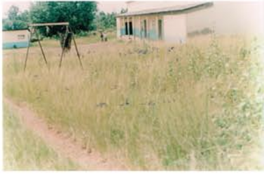
Edificio principal 4 aulas
