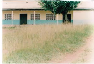
Edificio principal fachada
